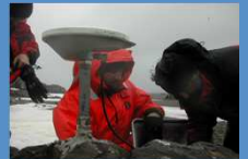
Construcción del vértice geodinámico MELU (isla Media Luna) de la red RGAE
